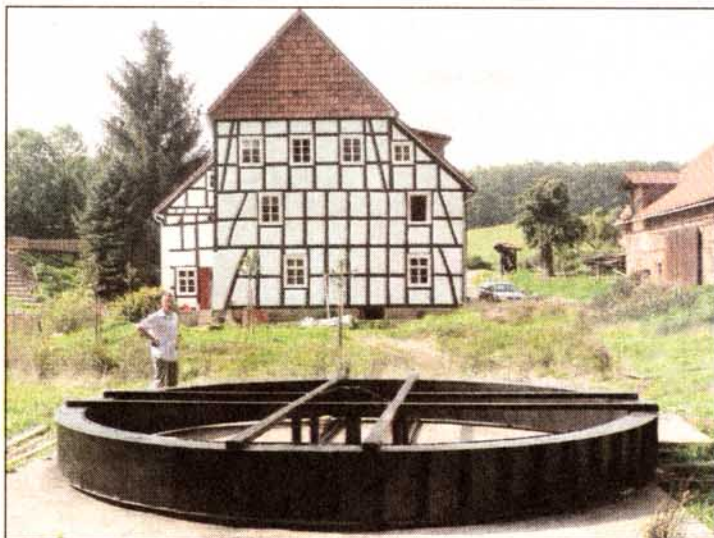
Nach historischem Vorbild gebaut: Das riesige Wasserrad für die Mühle Freienhagen.
