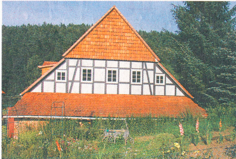
Blick auf die Giebelfront mit Bauerngarten: Die Sanierung der Außenfassade ist fertig gestellt.
