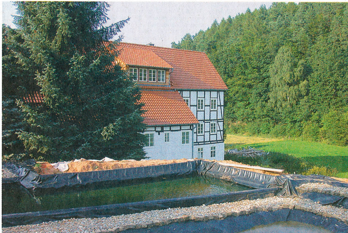
Blick auf die alte Mühle mit Wasserbecken im Vordergrund: Hier entstehen die Feuerlöschteiche.
