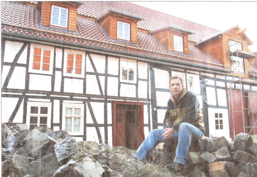
Die Fachwerk-Fassade schon herausgeputzt, das Dach völlig neu aufgestellt: Werner Liebchen vor der Unteren Mühle bei Freienhagen. Der Frankfurter erwarb das Anwesen im vergangenen Jahr und baut es seither aus und um. FOTOS: HERMANN
